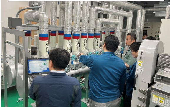
バルブ調整を指示して最大流量調整
