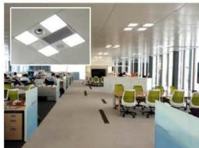
放射パネルと気流型パーソナル空調を併用した快適な空間
