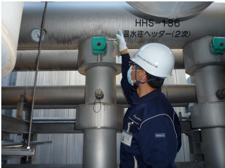
二次ポンプ吐出手動弁を調節し、末端空調機流量を定格流量以下に調整する様子
