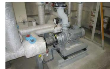
写真-11 冷水ポンプの更新(左:更新前 右:更新後)
