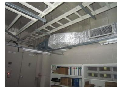
写真-15 電気室の外気冷房
