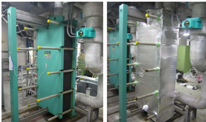
写真-13 熱交換器の施工状況
