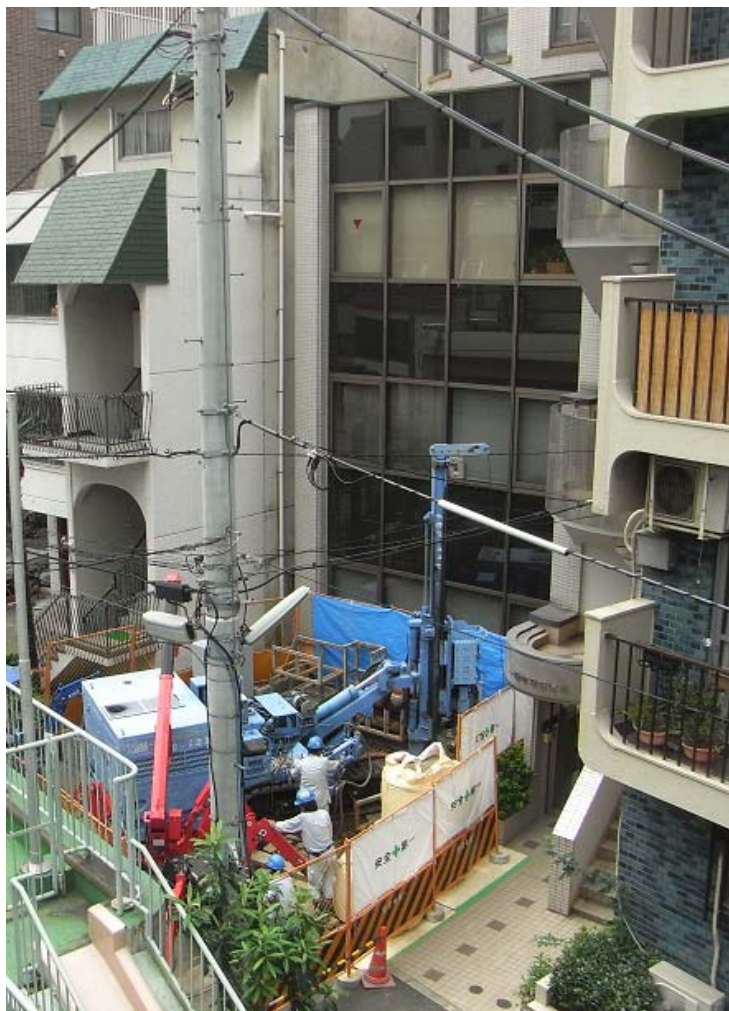
回転振動式掘削機での地中熱交換井の施工 施工期間：2008年9月1日～11月16日
