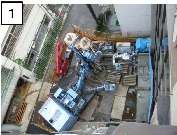
1 掘削（5階建ビル屋上から撮影）
