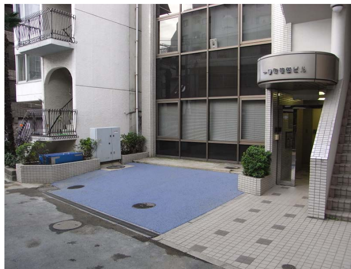
地中熱交換器を埋設した駐車場
