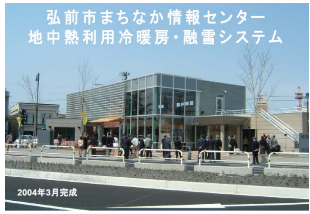
弘前市まちなか情報センター2004年4月運転開始(石上ほか 2010)
