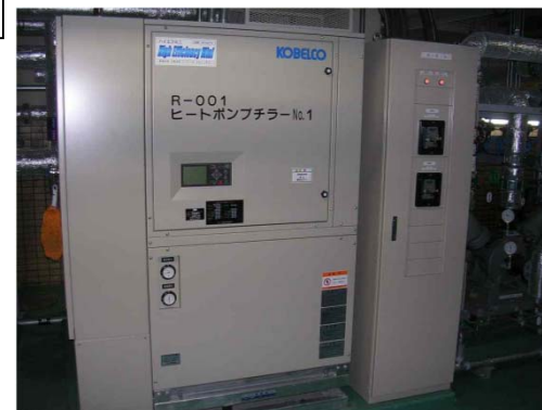
改修後のヒートポンプ 製氷能力190kW × 2台
